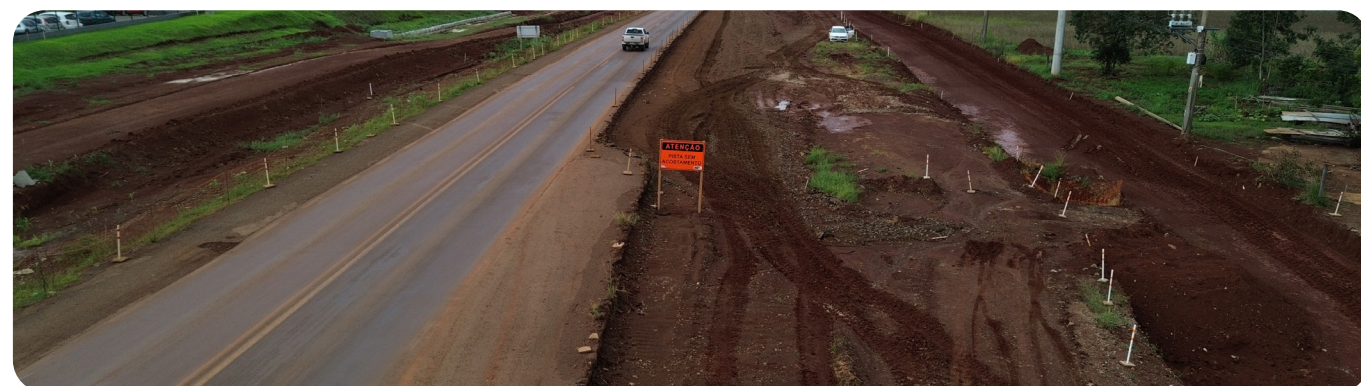
Registro das obras no km 454 (Abril/2026)
