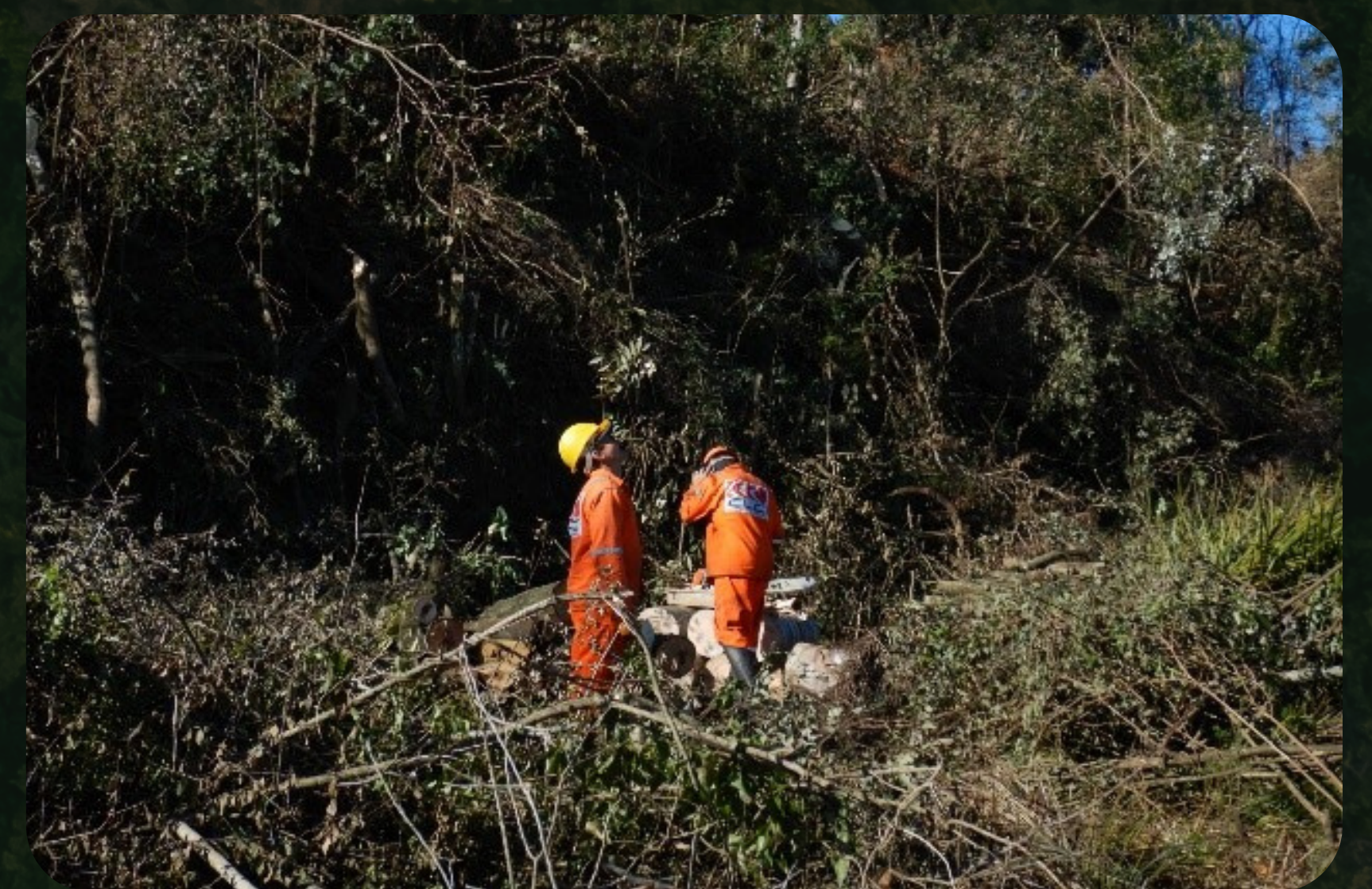
Trabalhadores executando a supressão vegetal.
