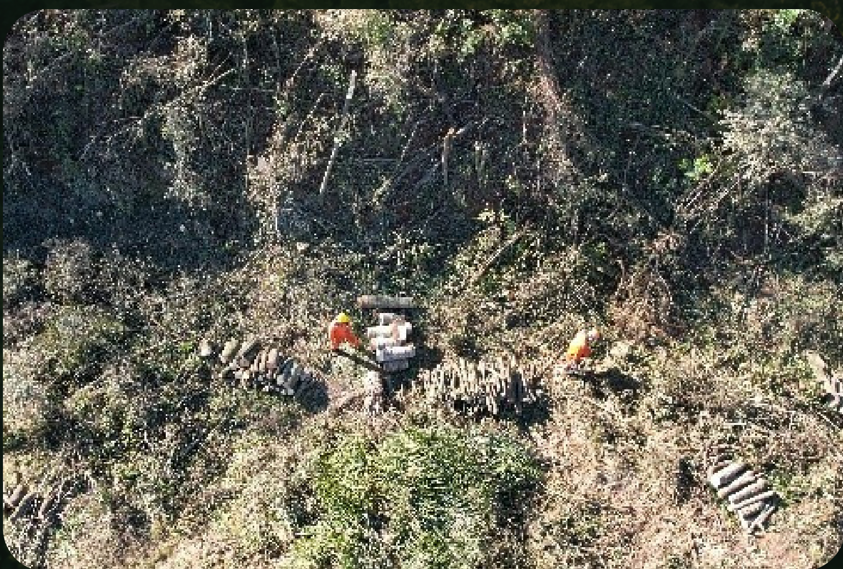
Trabalhadores executando a supressão vegetal.
