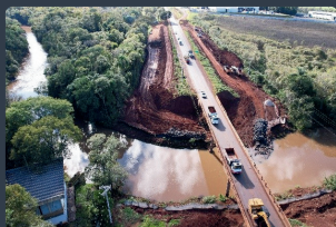
Vista superior do rio Potiribú: intervenções físicas para construção da nova ponte
