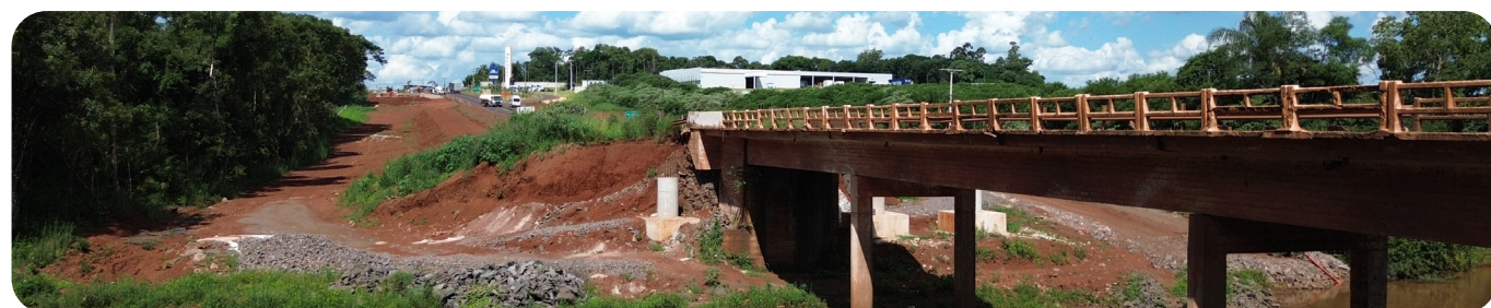
Registro das obras no Rio Potiribu (Janeiro/2026)
