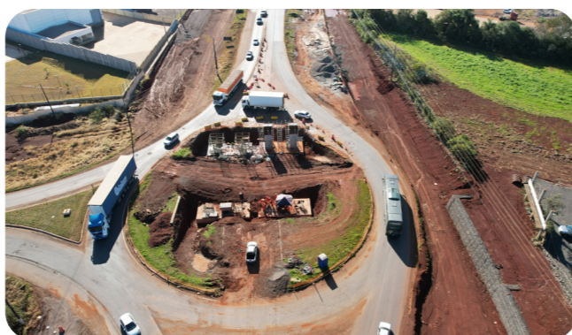
Pontos em obra em Outubro/2025
